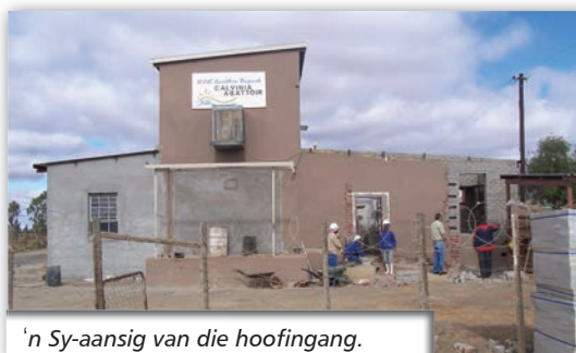
Konstruksie van die nuwe koelkamer (koelkamer-af-dak).
